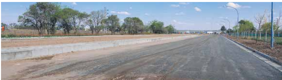
En dos frentes: las calzadas se encuentran en nivel de compactación y está en plena ejecución el sistema de desagües y drenaje.
