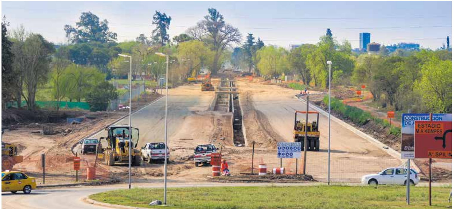
En marcha: continúan las obras que conectarán la rotonda oeste de acceso al aeropuerto con Bv. Los Alemanes.
