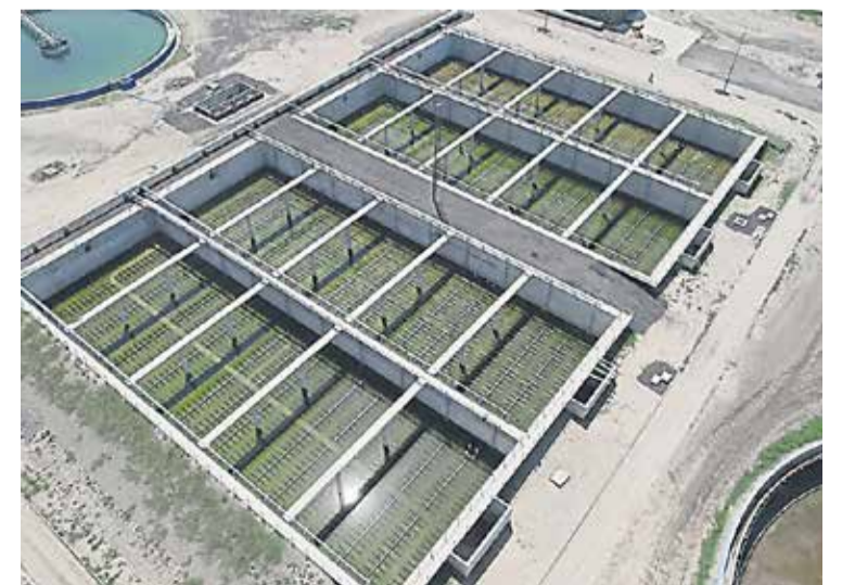
TANQUES DE AIREACIÓN. Se conectan con los sedimentadores secundarios, las estaciones de recirculación de lodos y la sala de cloración.
