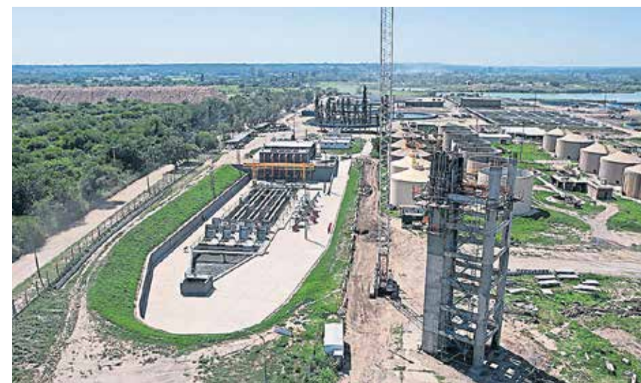
DESARENADOR/TREN DE INGRESO. Junto con las cribas y el desgrasado se integra el tren de pretratamiento.
